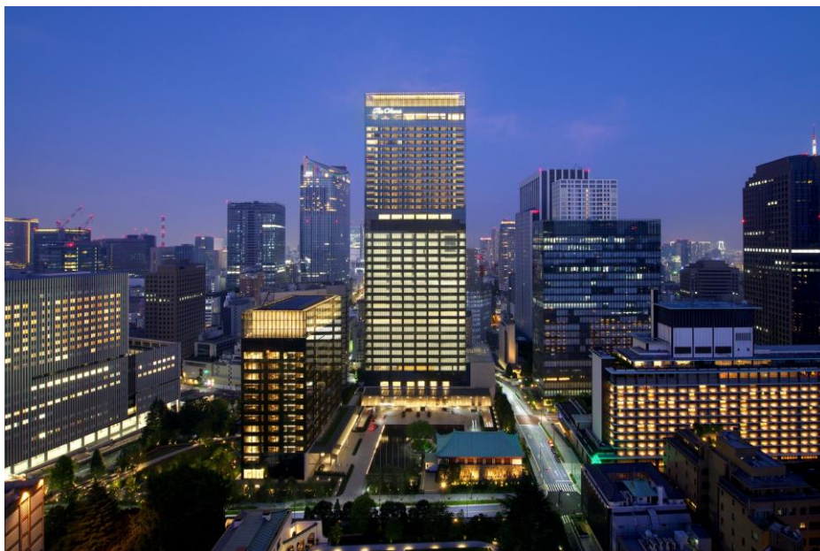
The Okura Tokyo 外観
